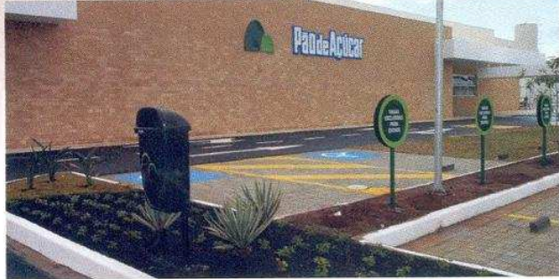
Localizada em Indaiatuba, interior paulista, loja "verde" do Pão de Açúcar foi sustentável desde a edificação
